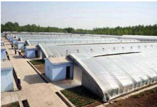
Внешне солнечный био-вегетарий похож на крыло самолёта, что обеспечивает эффективный прём солнечной энергии и снижает потери тепла при сильных ветрах в холодную погоду.
