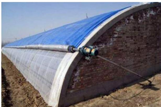
время суток закрывается специальным покрытием, имеющим фольгированный внутренний слой, позволяющий отражать световую энергию внутрь вегетария, что позволяет сохранить до 60% световой энергии для нормального фотосинтеза растений.
